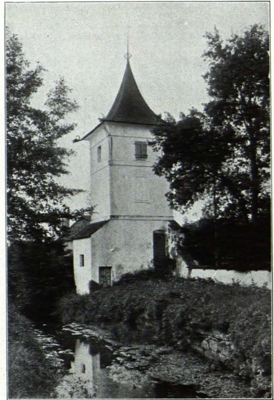
Fig. 396 Fronburg. Wasserturm (S. 414)
