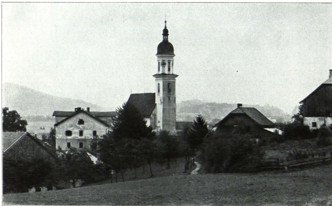
Fig. 305 Liefering. Filfalkirche, Ansicht von Nordwesten (S. 334)
