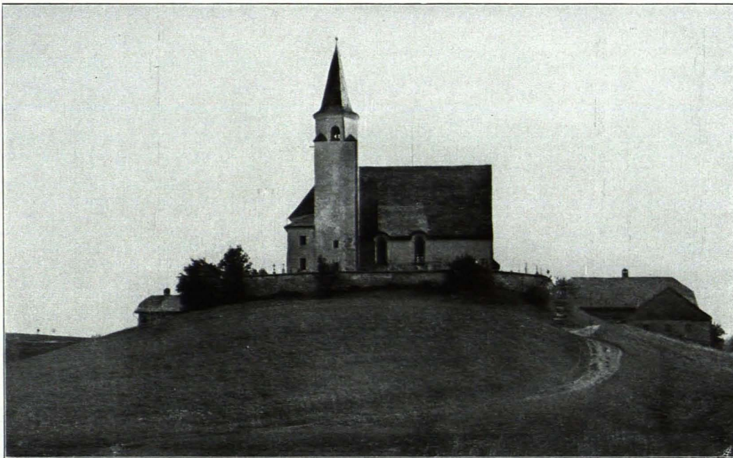
Fig. 250 Koppl. Pfarrkirche, Ansicht von Norden (S. 271)
