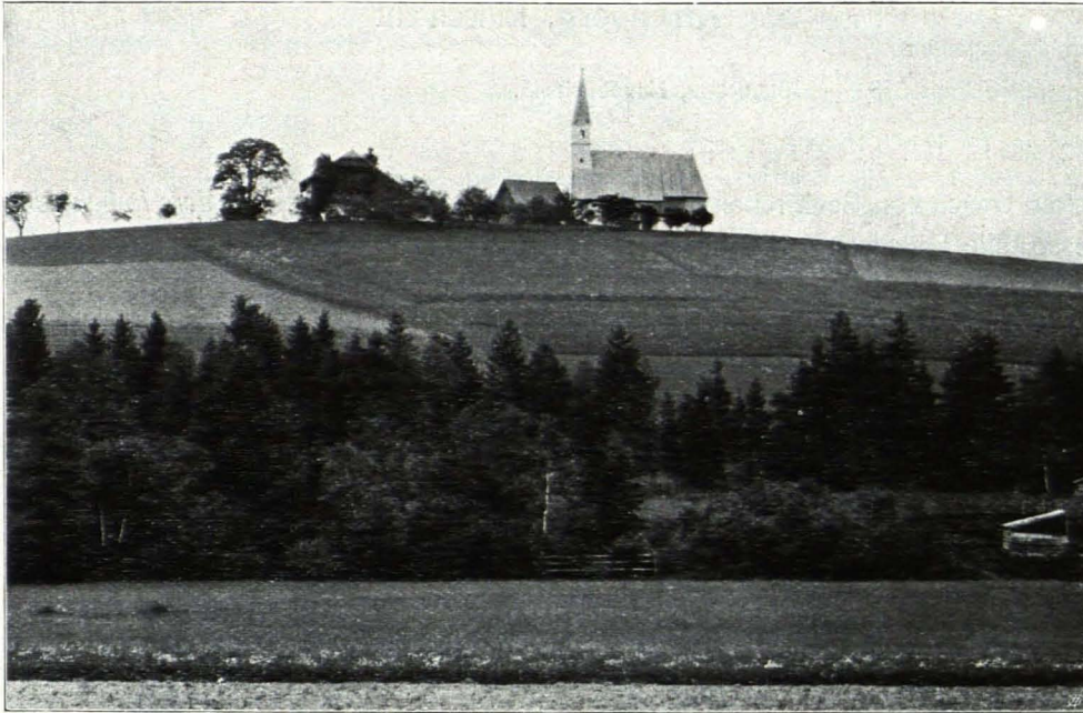
Fig. 242 Kirchberg. Filialkirche, Ansicht von Süden (S. 264)
