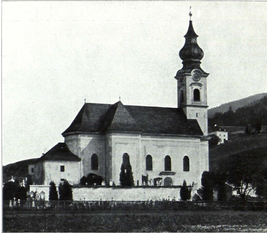
Fig. 86 Gnigl, Pfarrkirche von Nordwesten (S. 86)
