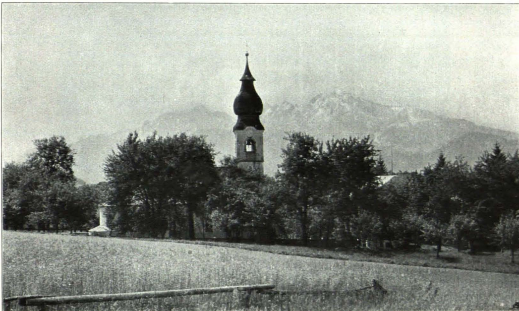
Fig. 43 Elsbethen, Kuratfilialkirche, Ansicht von Norden (S. 47)
