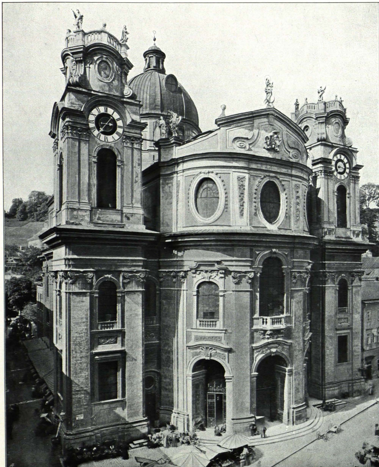
Fig. 276 Kollegienkirche, Fassade (S. 242)
