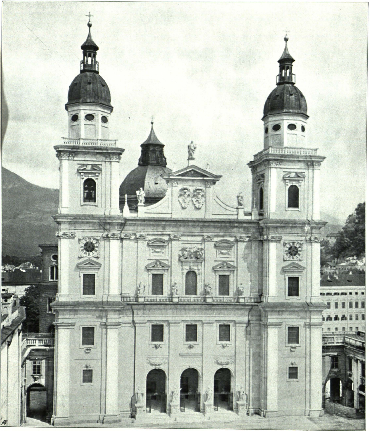
Fig. 8 Dom, Westfassade (S. 10)
