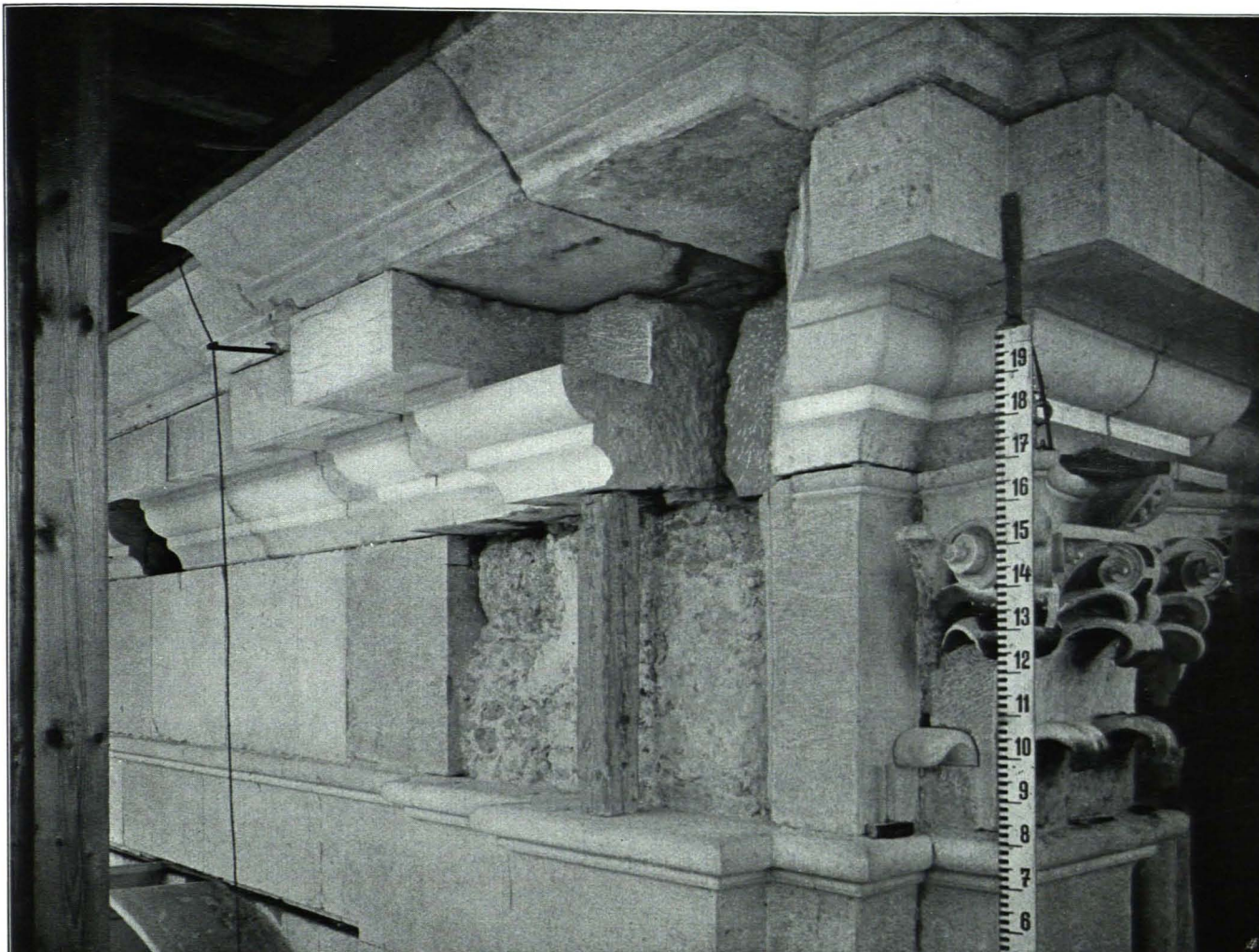
Fig. 12 Dom, Gebälk des Mittelfrontons der Fassade (während der Restaurierung) (S. 12)
