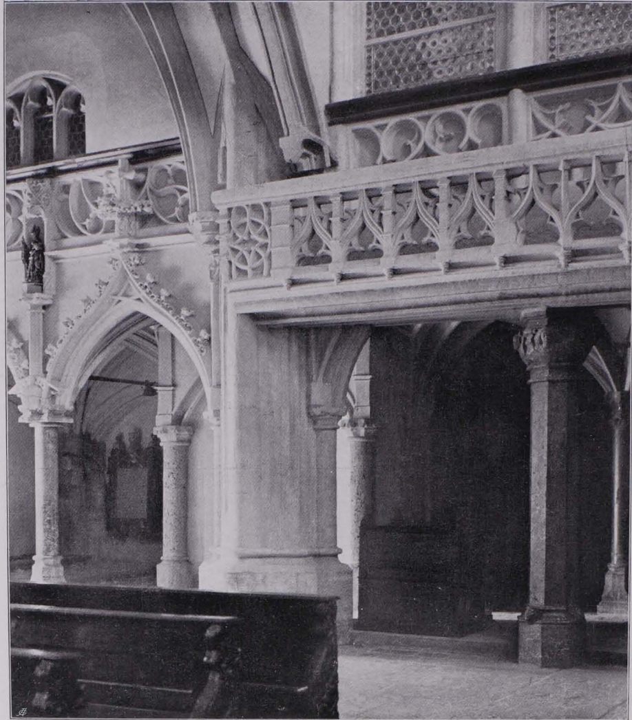
Fig. 25 Vorhalle unter dem Nonnenchor und Blick in die südliche Vorhalle (S. 16)
