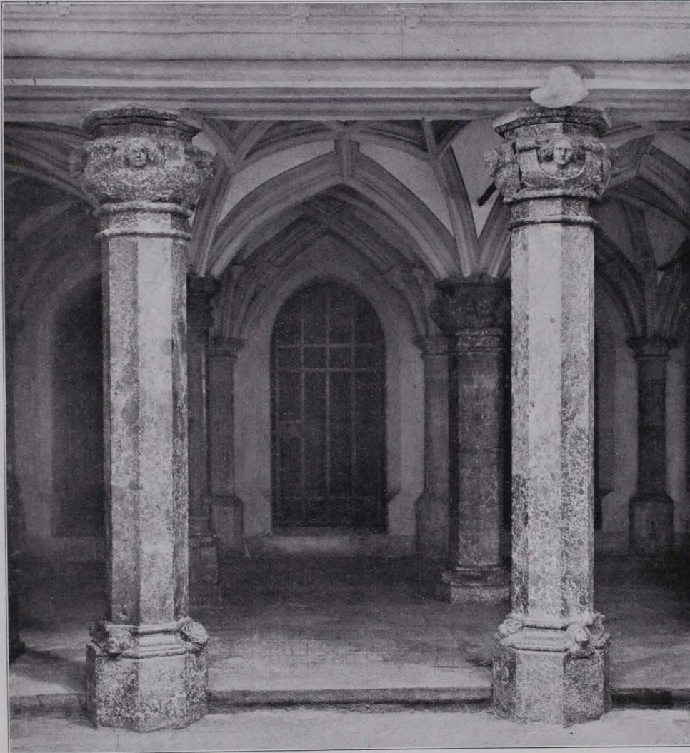
Fig. 26 Vorhalle unter dem Nonnenchor (S. 16)
