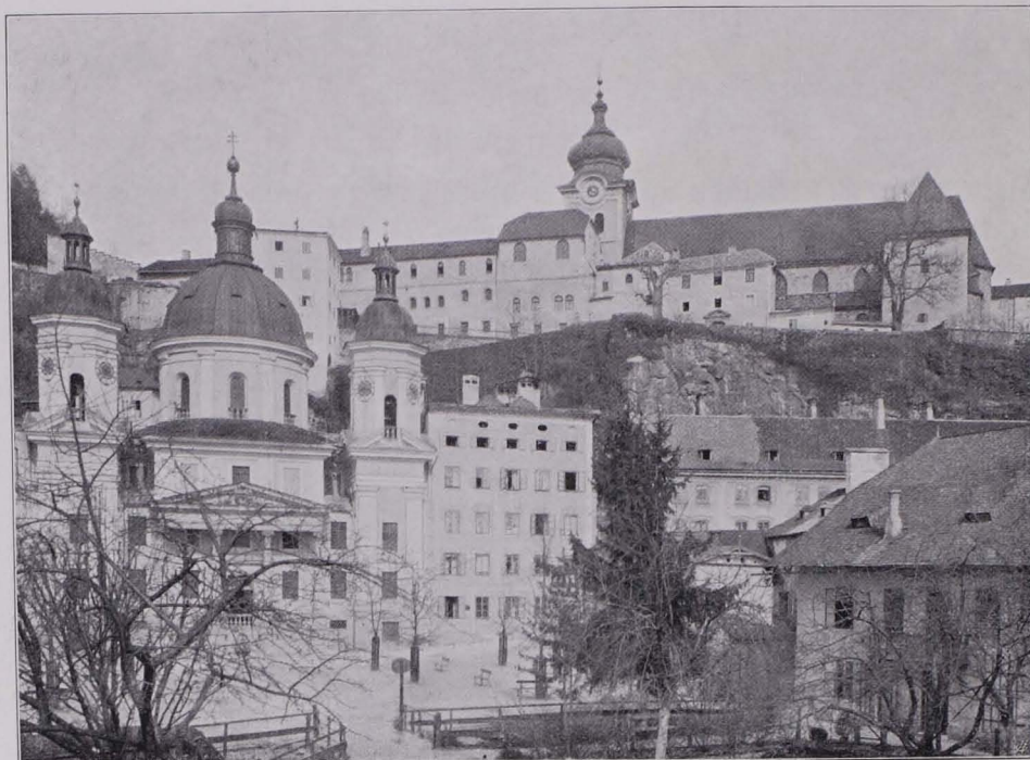
Fig. 7 Ansicht des Stiftes von Süden (S. 1)
