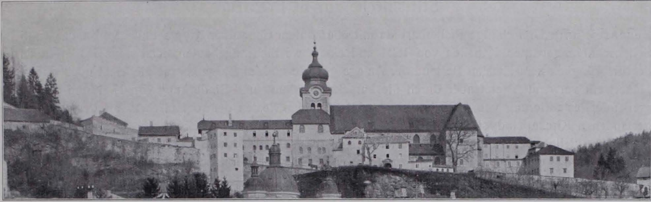
Fig. 6 Ansicht des Stiftes von Süden (S. 1)
