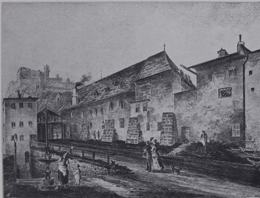
Fig. 5 Ansicht des Stiftes vor dem Umbau von 1885, nach einem Aquarell von Zeller im Stiftsarchiv (S. LXII)
