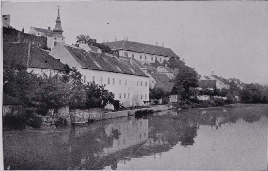
Fig. 145 Waidhofen an der Thaya, Ansicht von der Thayaseite (S. 146)
