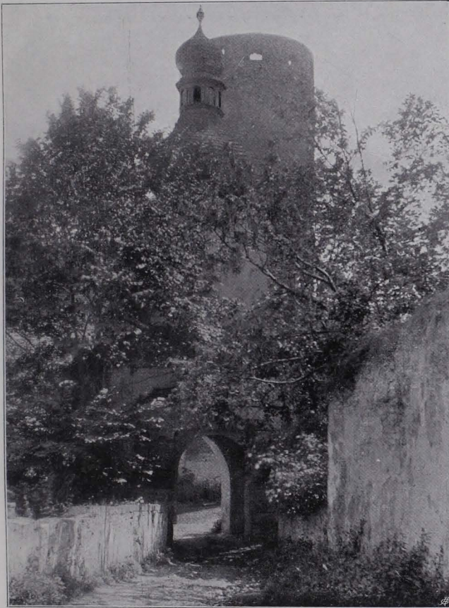
Fig. 30 Karlstein, Hauptzugang mit Torturm (S. 27)
