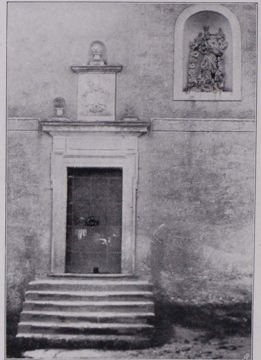
Fig. 122 Primmersdorf, Schüttkasten, Tür (S. 114)
