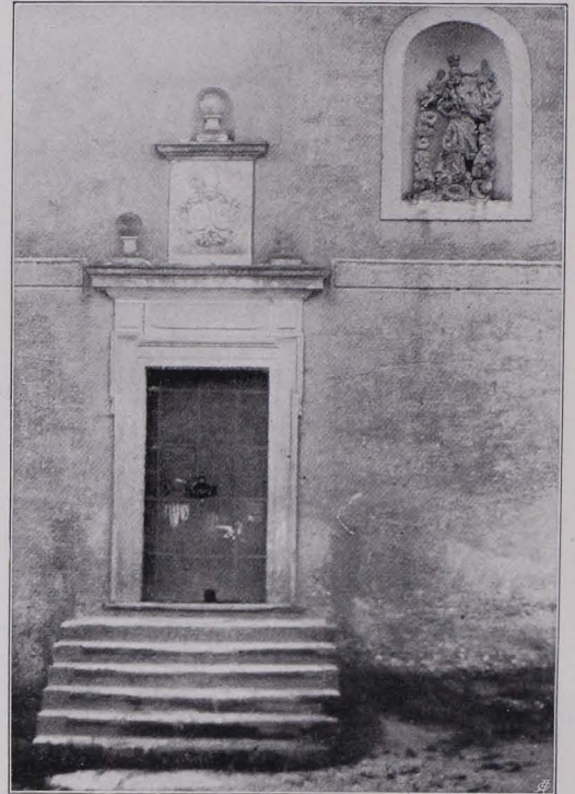
Fig. 122 Primmersdorf, Schüttkasten, Tür (S. 114)
