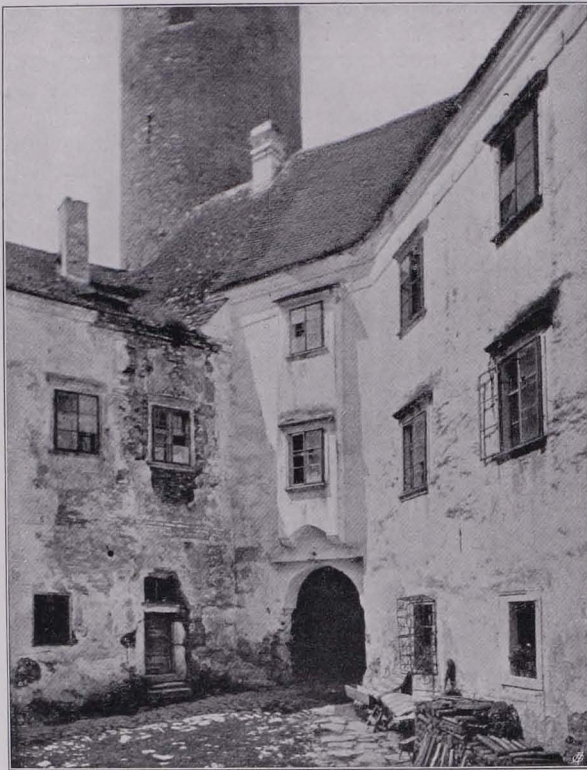
Fig. 31 Karlstein, Schloßhof, Nordwestecke (S. 27)
