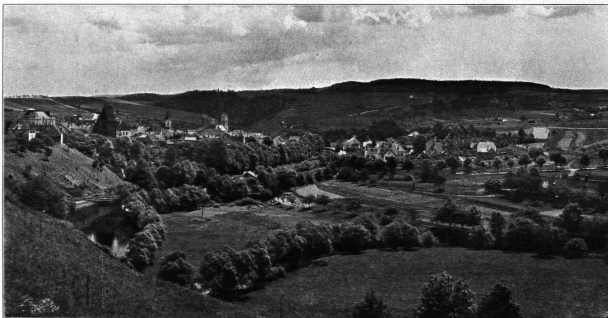
Fig. 389 Zwettl, Gesamtansicht von Nordwesten (S. 425)
