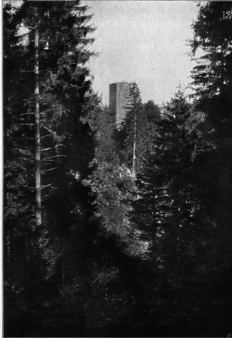
Fig. 294 Ruine Lichtenfels, Berchfrit, Ansicht von Westen (S. 315)
