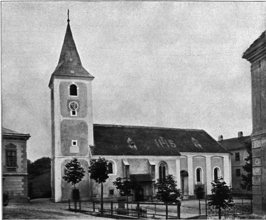
Fig. 215 Langschlag, Pfarrkirche, Ansicht von Süden (S. 247)
