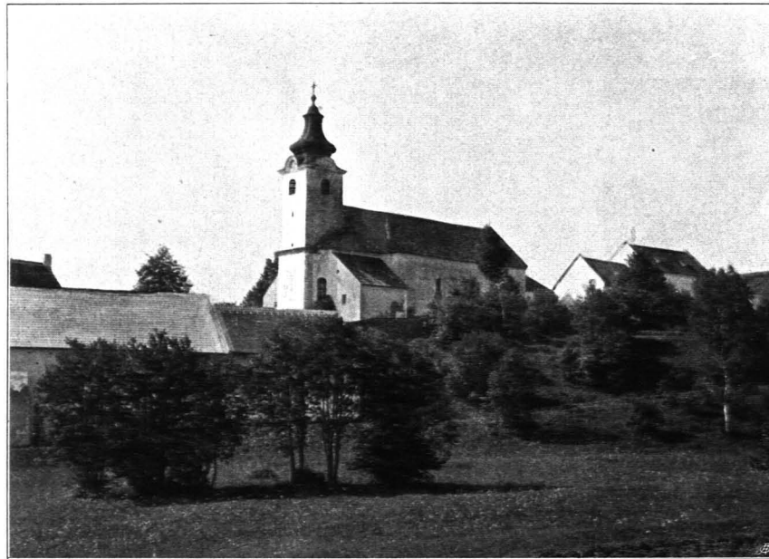
Fig. 340 Oberndorf, Pfarrkirche, Ansicht von Nordosten (S. 367)
