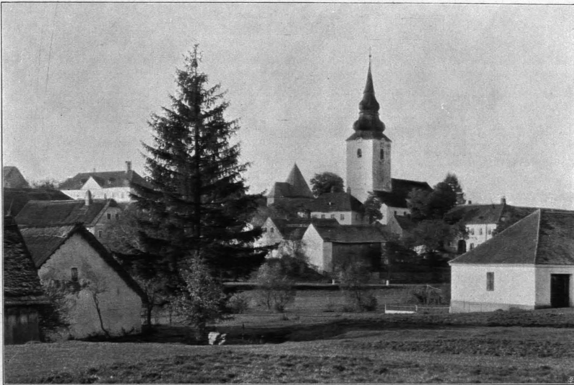
Fig. 300 Groß-Globnitz mit Pfarrhof, Karner und Pfarrkirche, Ansicht von Nordosten (S. 323)
