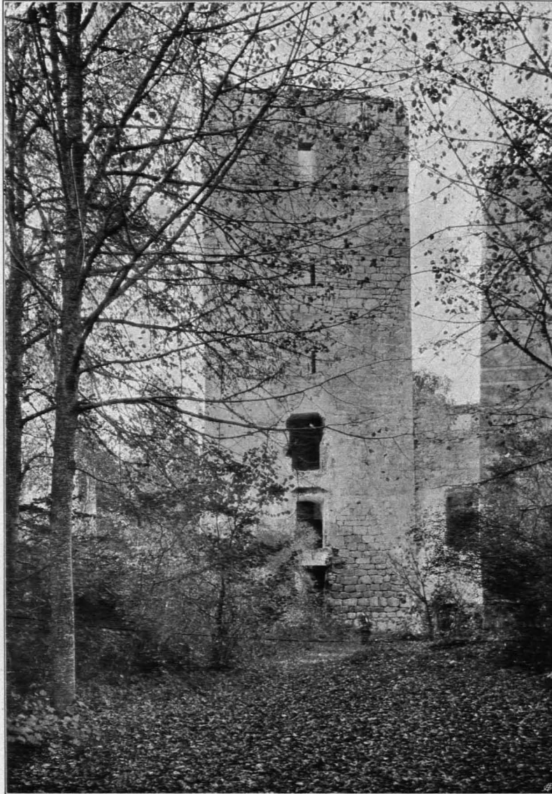
Fig. 295 Ruine Lichtenfels, Berchfrit, Ansicht von Süden, vom inneren Burghofe aus (S. 315)
