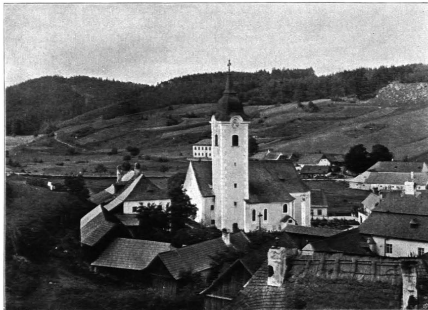
Fig. 210 Kirchbach, Pfarrkirche, Ansicht von Südwesten (S. 242)
