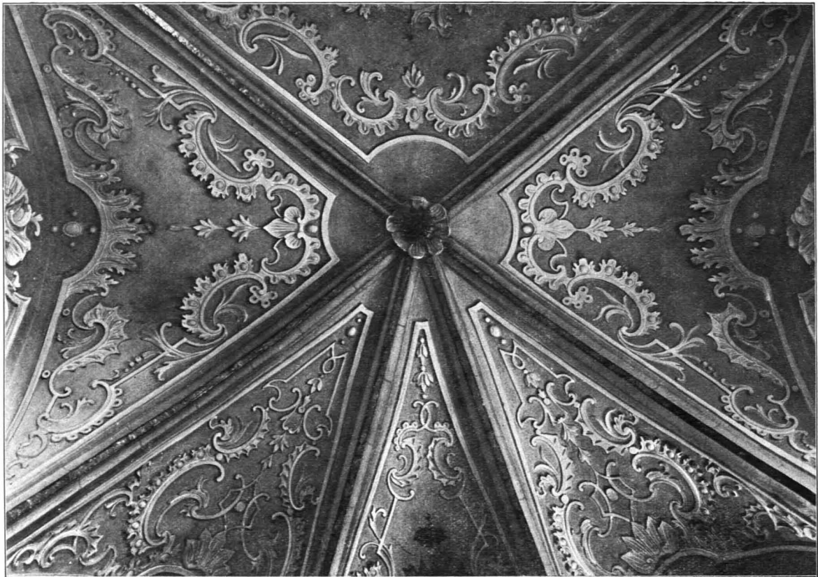
Fig. 192 Groß-Gerungs, Pfarrkirche, gotisches Gewölbe im Chore der Marienkapelle, mit stuckierten Rokokoornamenten (S. 227)
