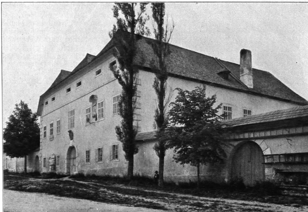
Fig. 181 Arbesbach, Herrenhaus, Ansicht von Südosten (S. 214)
