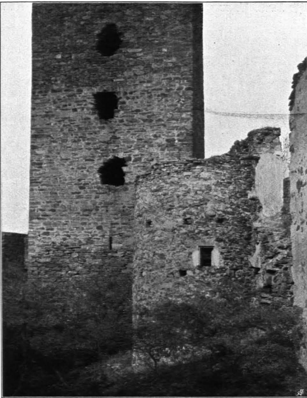
Fig. 130 Ruine Schauenstein, Berchfrit, SO.-Ansicht vom Hofe aus (S. 159)
