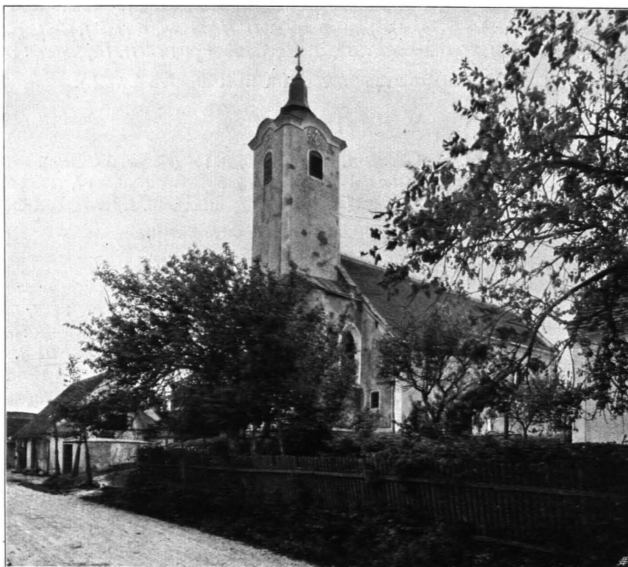
Fig. 32 Edelbach, Pfarrkirche, Ansicht von Nordosten (S. 34)
