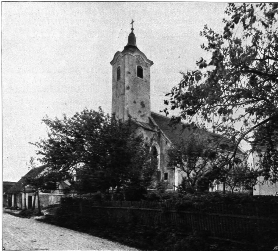
Fig. 32 Edelbach, Pfarrkirche, Ansicht von Nordosten (S. 34)
