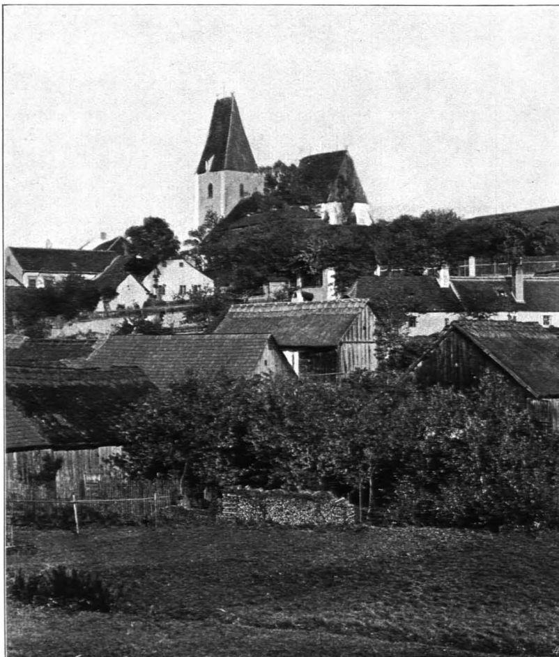
Fig. 22 Döllersheim, Ansicht von Südosten (S. 19)
