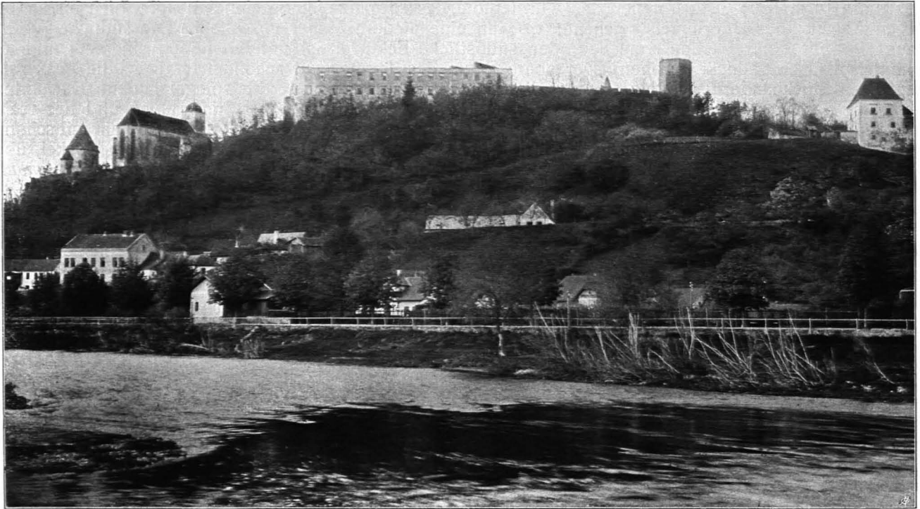
Fig. 640 Thunau, Gesamtansicht (S. 528)
