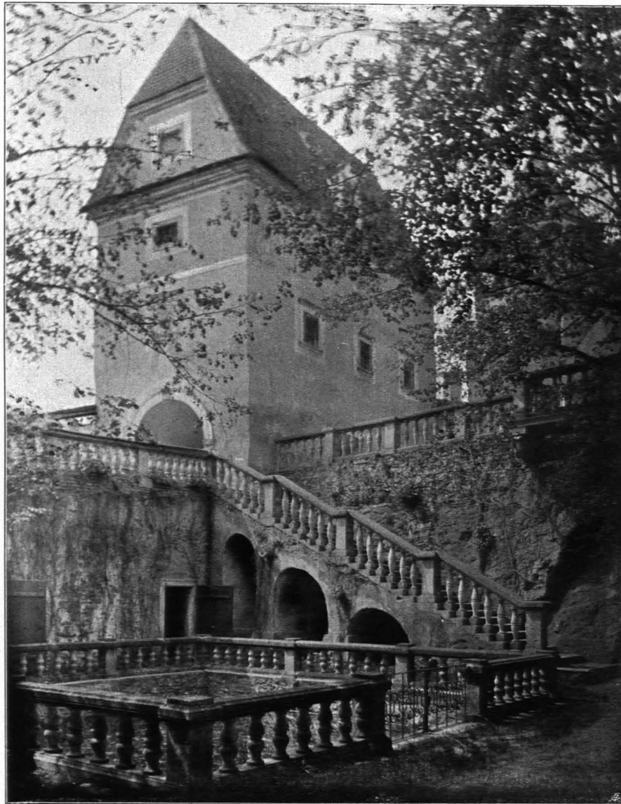
Fig. 614 Schloß Rosenberg, Nördliche Hälfte des Vorhofs mit Bassin (S. 511)
