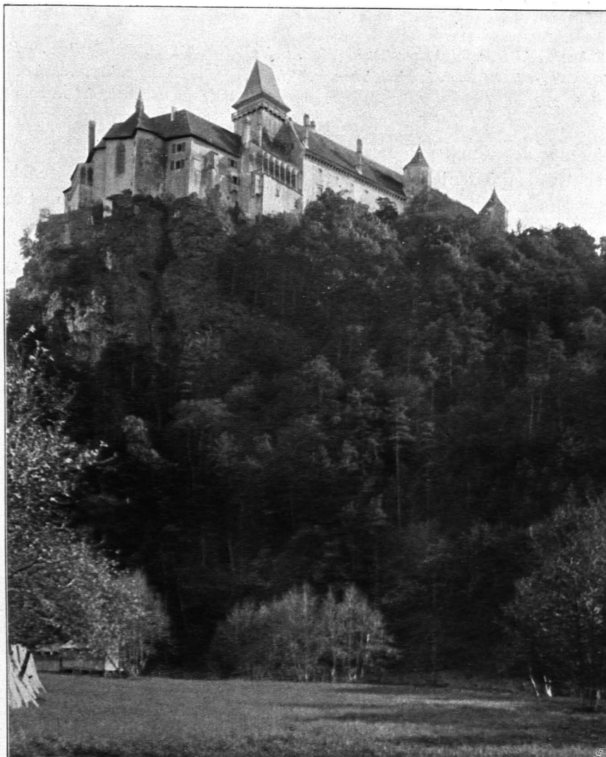
Fig. 601 Schloß Rosenberg, von der Straße nach Altenburg gesehen (S. 502)
