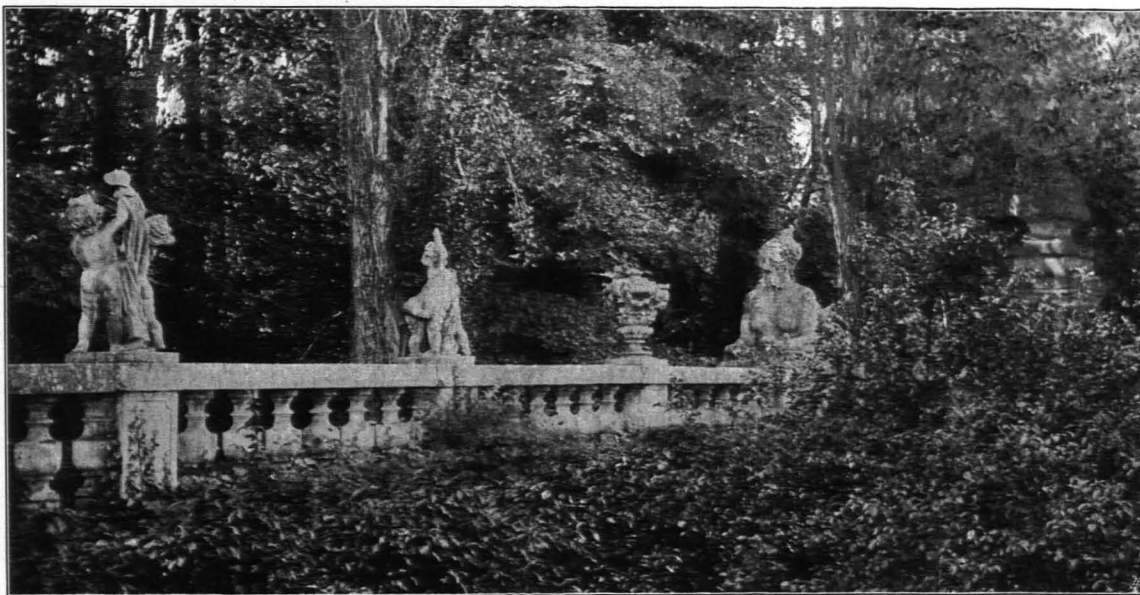
Fig. 593 Greillenstein, Balustrade des Schloßgrabens (S. 498)
