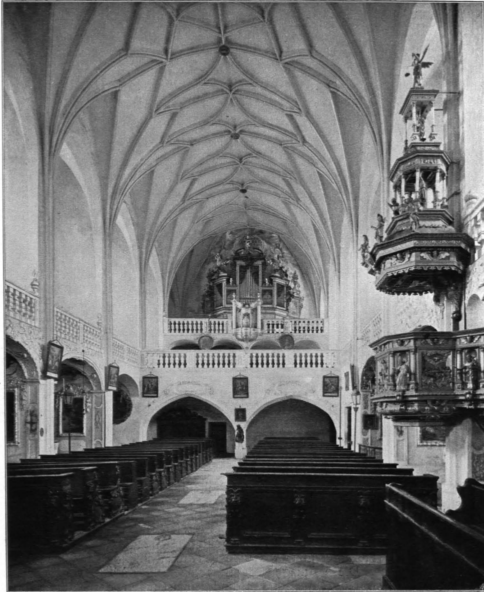
Fig. 520 Pernegg, Pfarrkirche, Blick gegen die Emporenanlage (S. 448)
