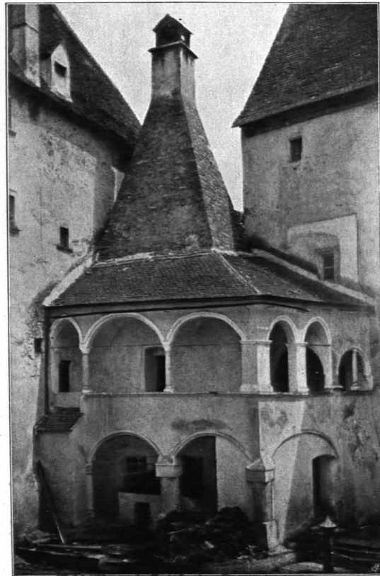
Fig. 478 Nordostecke des Schloßhofes (S. 415)
