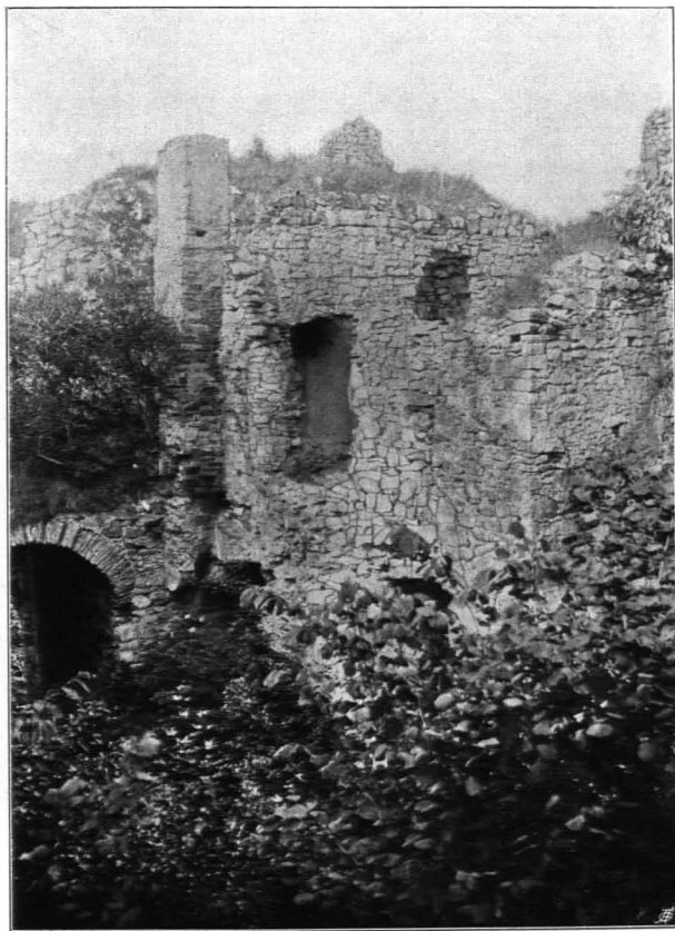
Fig. 471 Grub, Ruine, Innenhof (S. 410)
