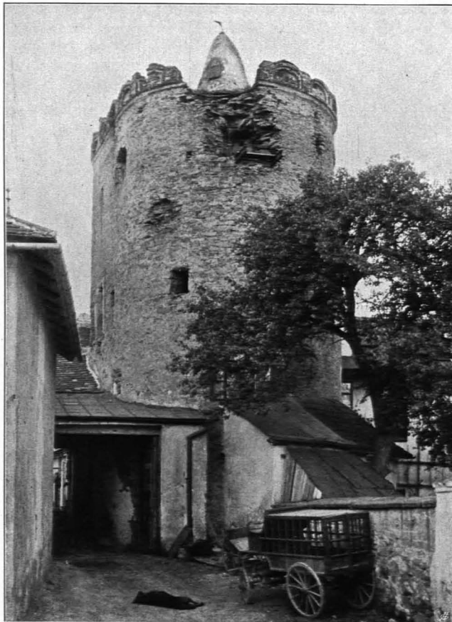
Fig. 444 Horn, Turm der alten Stadtbefestigung (S. 389)
