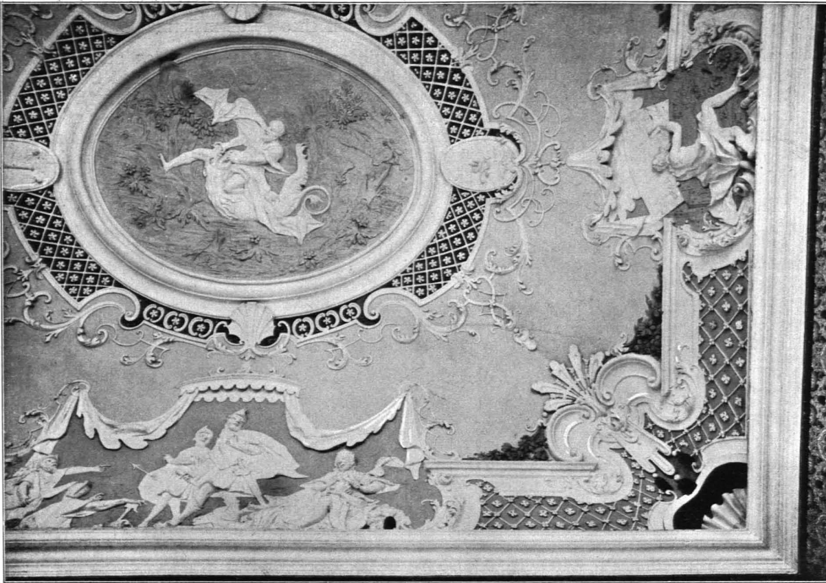
Fig. 331 Altenburg, Stift, Kaiserzimmer 1, Deckendetail (S. 301)
