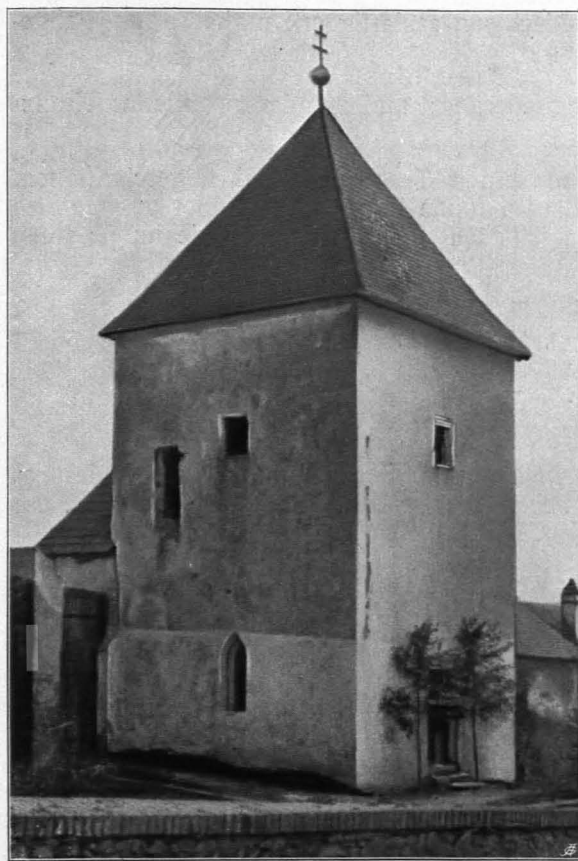
Fig. 111 Missingdorf, Turmkapelle (S. 100)
