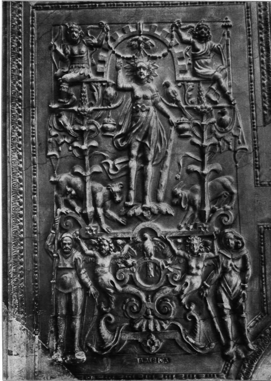
Fig. 48 Eggenburg, Landeserziehungsanstalt, Detail von der zerstörten Decke im sogenannten Schlosse (S. 48)
