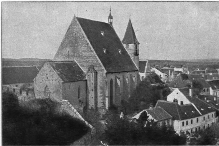
Fig. 13 Eggenburg, Pfarrkirche, Ansicht von Westen (S. 23)
