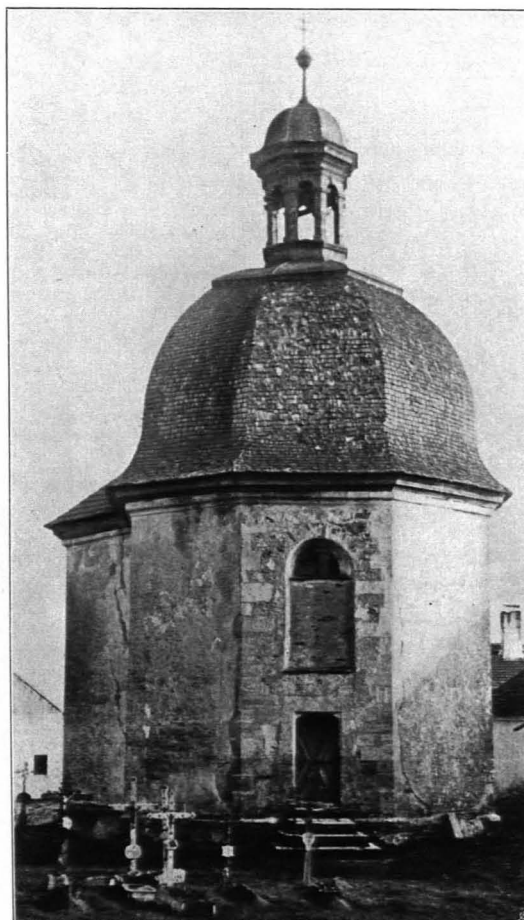
Fig. 508 Neukirchen an der Wild, Karner, 1897 demoliert (S. 439)
