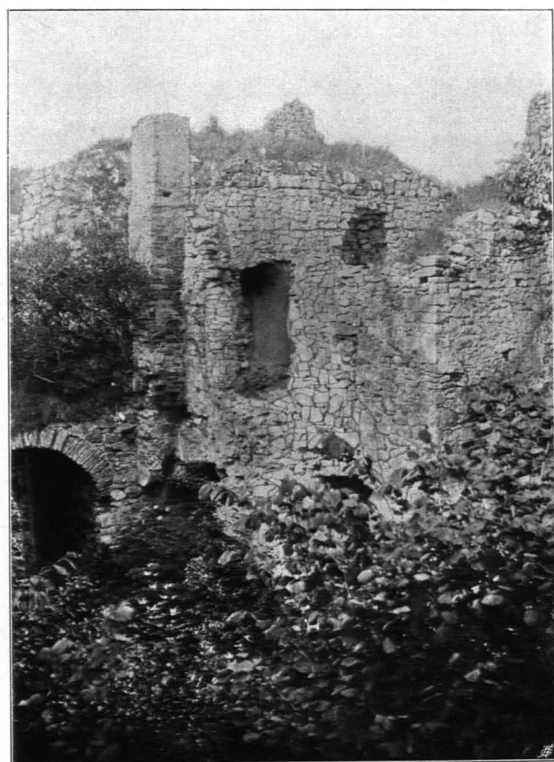
Fig. 471 Grub, Ruine, Innenhof (S. 410)
