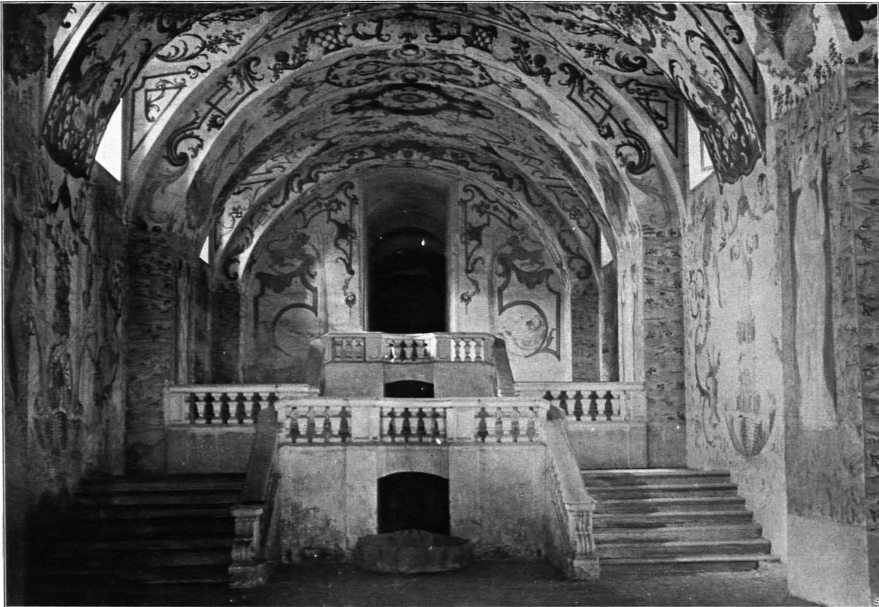
Fig. 355 Altenburg, Stift, Krypta mit Treppenanlage (S. 316)
