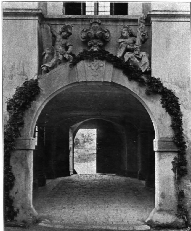
Fig. 296 Altenburg, Stift, Portal im Nordtrakt (S. 274)
