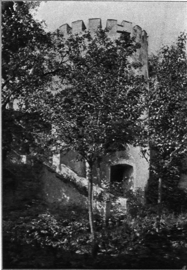
Fig. 199 Geras, Alter Befestigungsturm im Garten (S. 183)
