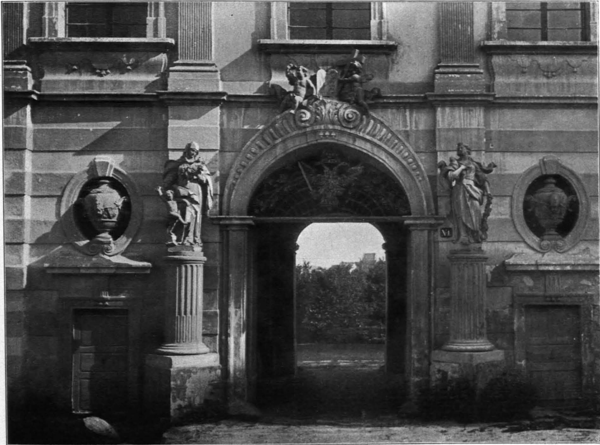
Fig. 227 Geras, Südtrakt des Stiftsgebäudes, Erdgeschoß des Mittelrisalits (S. 201)
