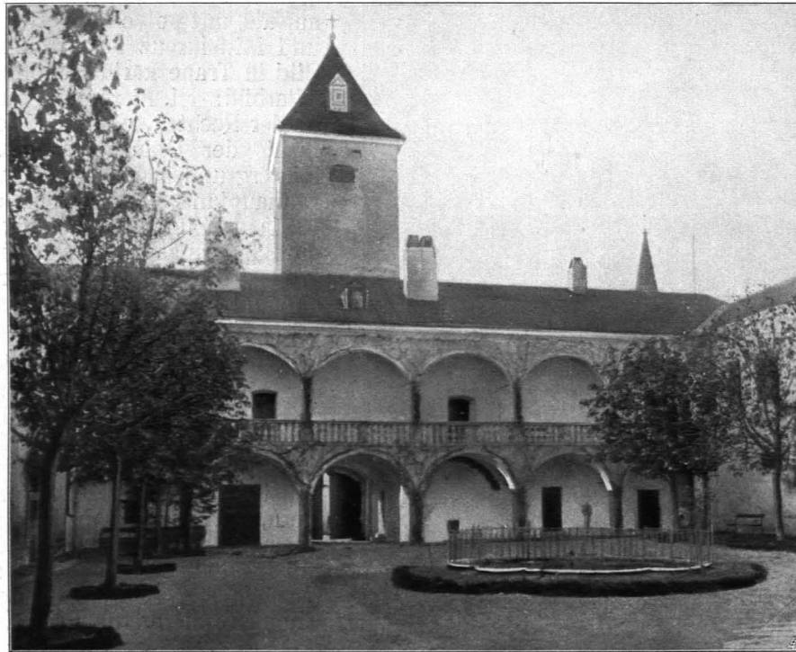
Fig. 151 Walkenstein, Gutshof (S. 140)
