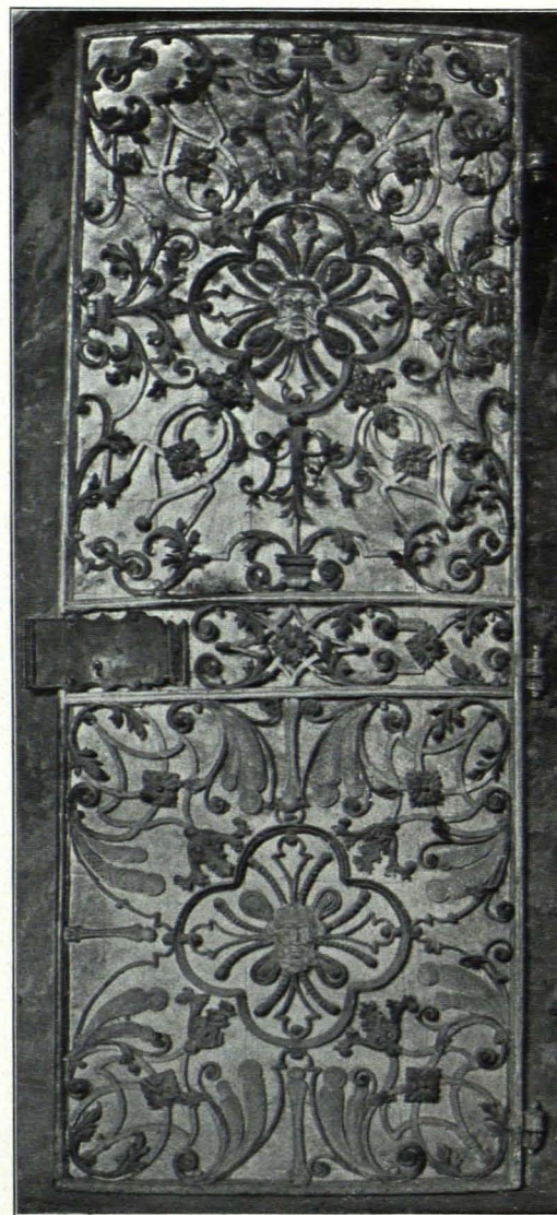
Fig. 107 Maria-Taferl, Gittertüre (S. 105)
