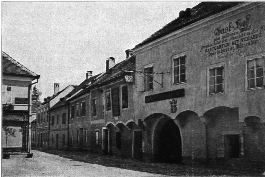
Fig. 417 Pöchlarn, Häuser 28 und 29 (S. 397)
