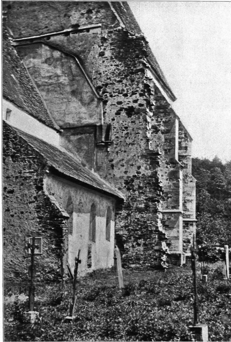
Fig. 188 Mauer, Pfarrkirche, Westwand des Chores (S. 152)
