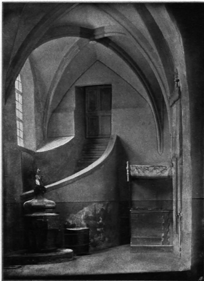
Fig. 135 St. Leonhard, Pfarrkirche, Emporenstiege (S. 109)
